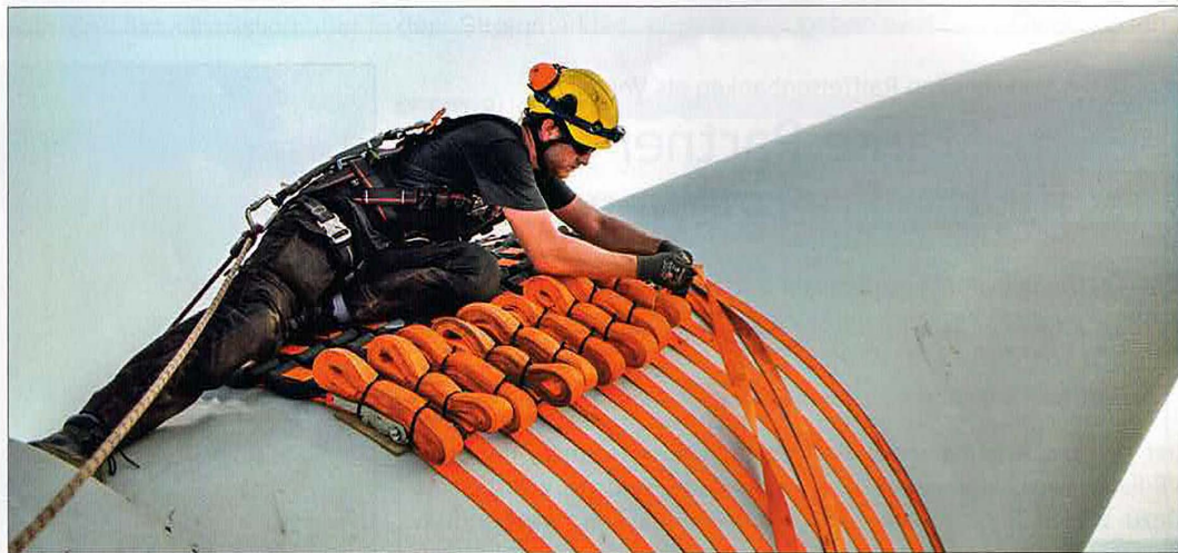
Am Rotorblatt werden Testgewichte angebracht.
